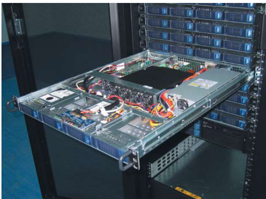
Сервер-«кирпичик» в конструкции суперкомпьютера «Т-Платформ»
